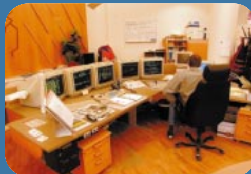
◀ ELRUMMET. I eldriftcentralen arbetar 2 personer i skift för att se till att det alltid finns spänning på luftledningarna, signalkraft till signalanläggningen, värmespänning i uttagen för vagnsvärme och 130 kilovolt på banverkets eget distributionsnät. Man tar också emot felanmälningar på järnvägsnätet och skickar ut reparatörer.
