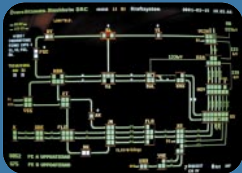
▲ HÖGSPÄNNINGSSHEMA. Systemet SPIDER från ABB Network Control används för att visa och övervaka omformarstationer, kopplingscentraler och elkopplare på linjer och bangårdar. Bilden visar hela det kontrollerade området. De tunna linjerna är 130 kilovolt och de grova 16 kilovolt. Det här är alltså inte tågspår utan högspänningsledningar. ÅS är Älvsjö, HGV är Häggvik, BAL är Bålsta och så vidare och är namnen på omformarstationer (och järnvägsstationer, märk väl!).
