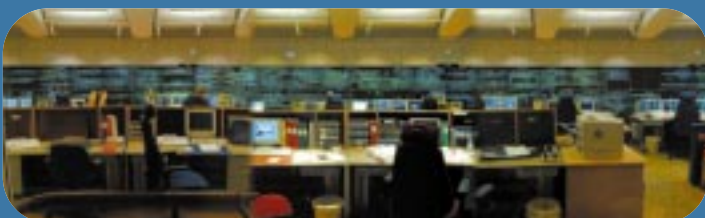
▲ SIGNAL-PANORAMA. Har du någonsin sett en större bildskärm? I ledningscentralen visas hela det kontrollerade området på 62 projektor-TV-skärmar från Barco, på en 40 meter lång display, styrd av Adtranz Signals EBICOS 900-system. Längst till vänster finns Katrineholm och längst till höger ligger Avesta/Krylbo. Lite till vänster om mitten ligger Stockholm. 40-metersskärmen är dock bara översiktlig och varje trafikledare kan zooma in till önskad detaljnivå på sina egna bildskärmar. En närmare beskrivning av hur tågklaring går till finns i texten.
