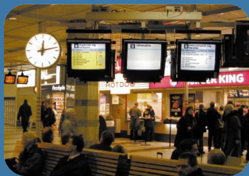
▲ ▼ TIDSUPPLYSNING + SKYLTY. EBICOS 900 matar också ut data till upplysningskärmar för resenärerna och skyltarna på plattformarna, via systemet Tetras. Det är dessutom trafikledarnas uppgift att göra högtalarutropen på stationerna inom distriktet. Det finns bildskärmsystem av flera årsmodeller för pendeltåg och fjärrtåg, helgrafiska såväl som alfanumeriska. Den allra senaste syns lite i bakgrunden, har orange bakgrund och gäller för Arlandabanan.
