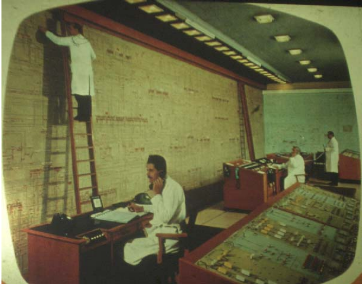
Figur 20 En stor översiktspanel från 1950-talet. Processen är ett elkraftnät. Bild tillhandahållen av ABB
